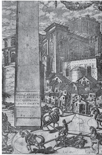
Рис. 5. Натале Бонифацио и Джованни Гуэрра. Обелиск и капелла хора Сикста IV (справа). Фрагмент из «Переноса обелиска» (Orbaan J.A.F. Op. cit. S. 1–139. Abb. 3)
